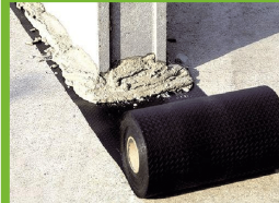
Izolacja pozioma muru
